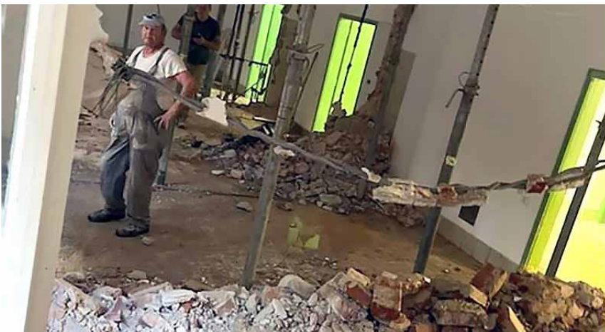
Del pritličja med obnovo ...
